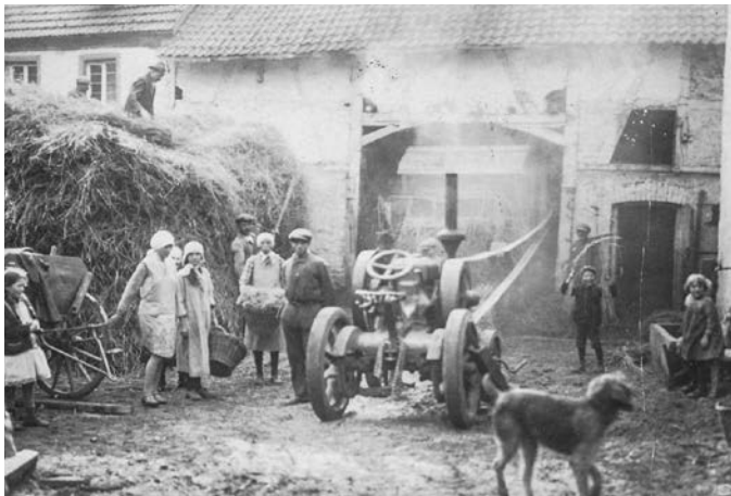
links: Im Jahr 1928 bereits ein gewaltiger Fortschritt: Eine über Transmissionsriemen angetriebene Dreschmaschine ist in der Trouden-Scheune aufgebaut.
