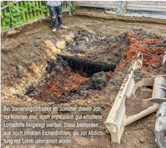
Bei Sanierungsarbeiten im Sommer diesen Jahres konnten drei, noch erstaunlich gut erhaltene Lohschiffe freigelegt werden. Diese bestanden aus noch intakten Eichenbohlen, die zur Abdichtung mit Lehm ummantelt waren.
